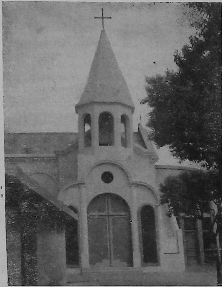
Vista del frente de la Iglesia Armenia "San Jorge" de Córdoba.
