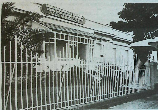
Entrada principal, de la sede de U.G.A.B.. Al frente, el nuevo enrejado.
