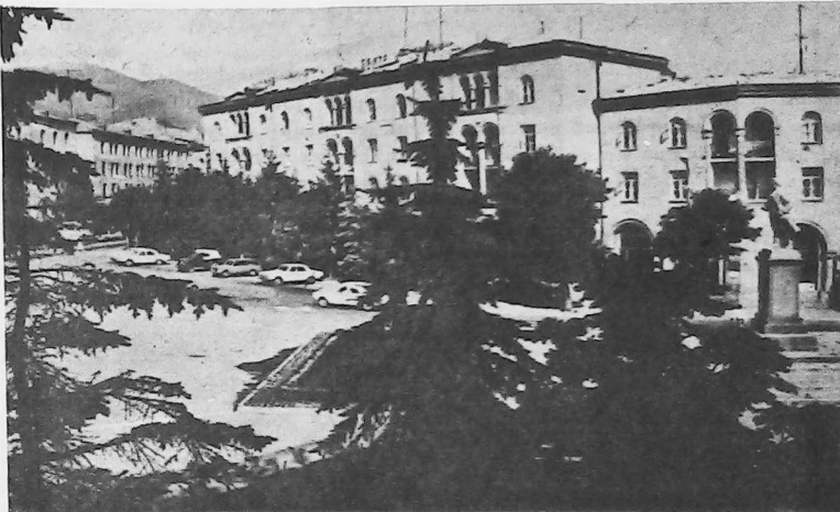
KIROVAGAN. Edificio de viviendas familiares.
