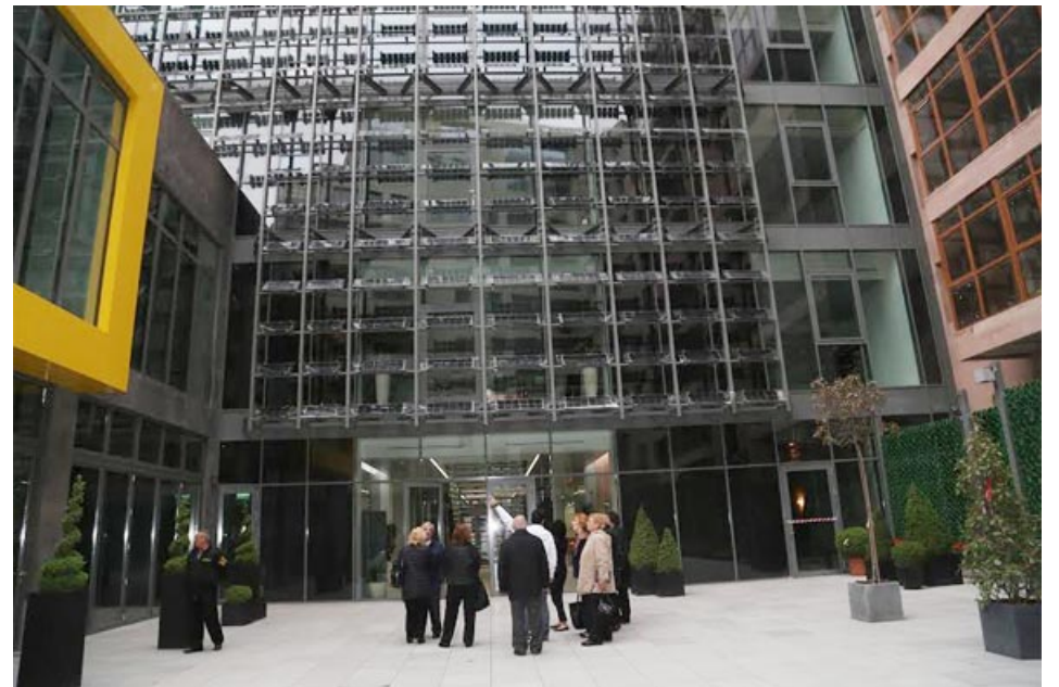
Desde el patio de la planta baja, se observan en el contrafrente los paneles de energía solar en todos los pisos.
